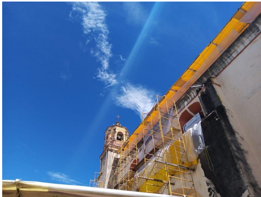
Fotografía 16. Templo de Santo Domingo en reparaciones
