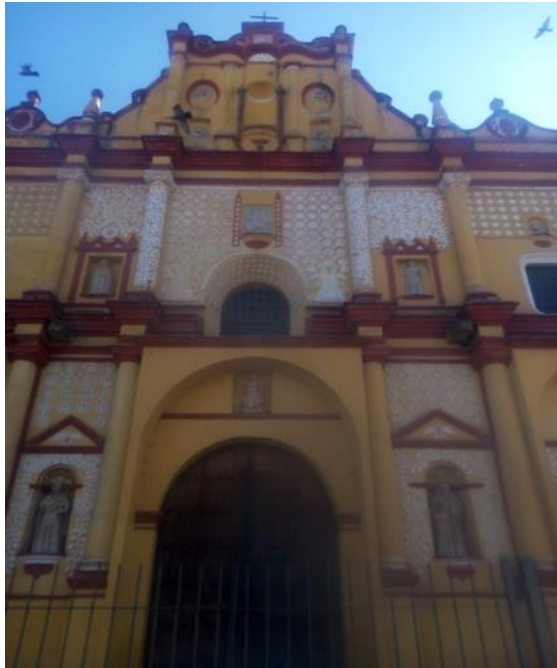
Fotografía 3. Fachada frontal de la catedral
