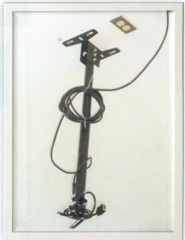
Soportes universal para pared o techo, con extensión ajustable, colocadas en techos de las aulas
