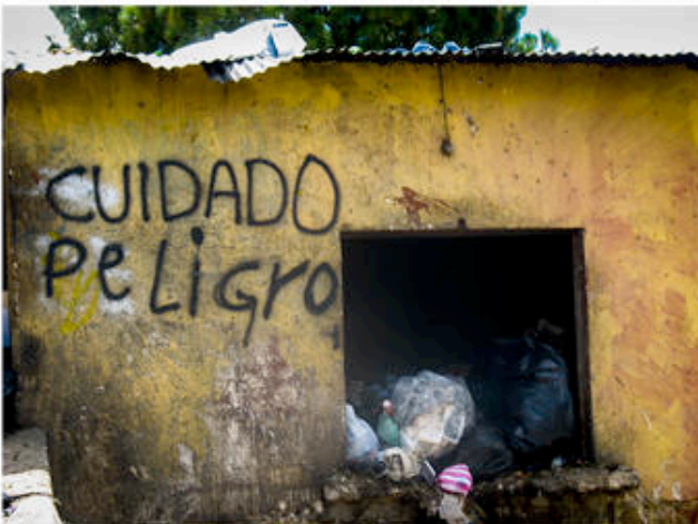
Foto 39: Centro de Transferencia El Tivoli, ubicado al costado de un canal de un río.
