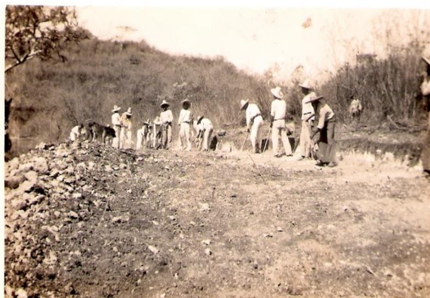
Figura 10. Reparación de caminos 1910 (Fuente: Archivo Histórico de Las Rosas, Chiapas)
