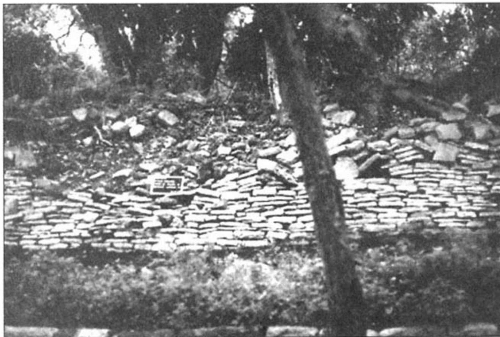
Foto 3. Reposición de piedra en las estructuras laterales del Juego de Pelota
