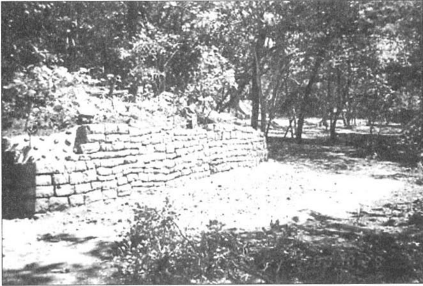
Foto 7. Esquinas nucleadas. Estructura XVII
