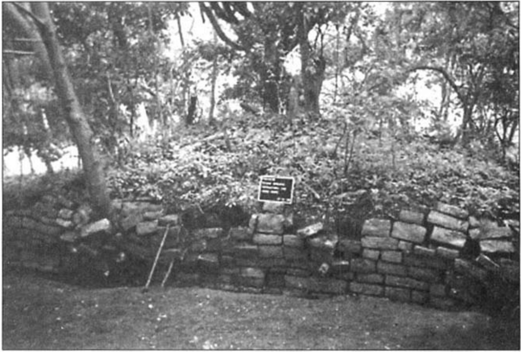
Foto 5. Liberación del muro oeste. Estructura XVII
