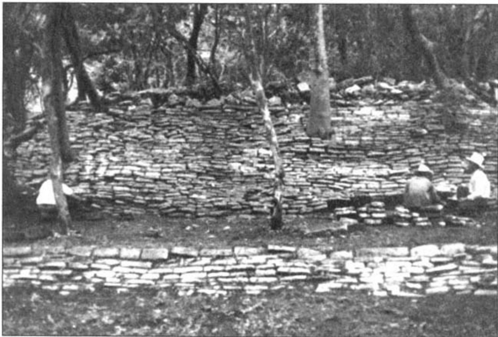
Foto 2. Proceso de anastilosis en las estructuras laterales del Juego de Pelota
