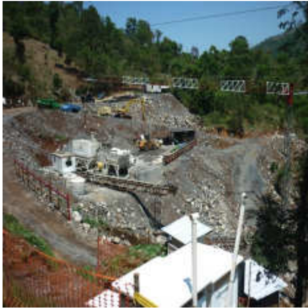
Construcción de la cortina en Palulca.
