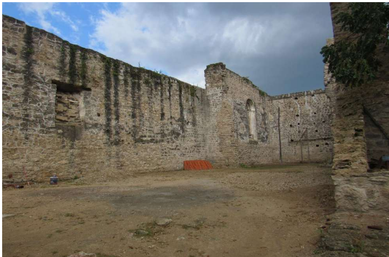
Nave de la iglesia
