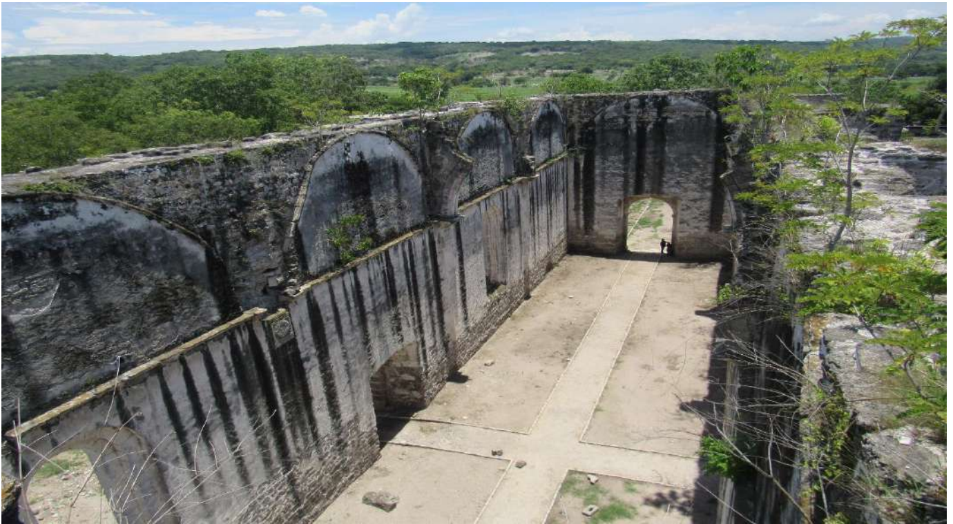
Nave del ex convento de Copanaguastla
