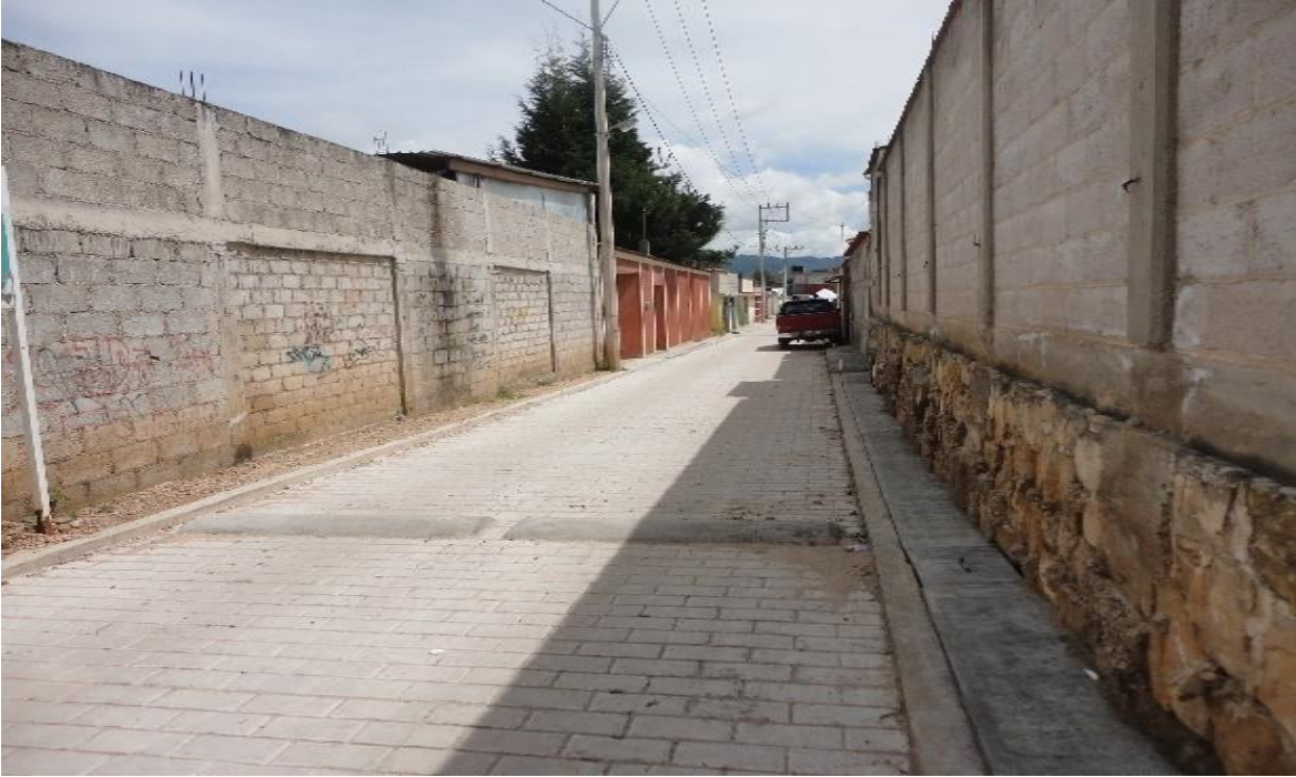
Pavimentación de la entrada de la colonia.
