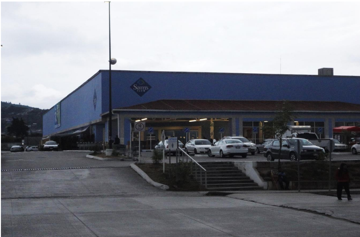
Construcción de tiendas comerciales.
