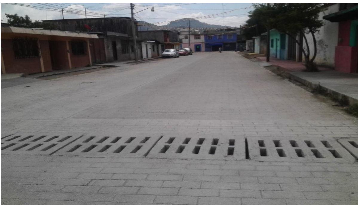
Construcción de dren pluvial y pavimentación de calles.
