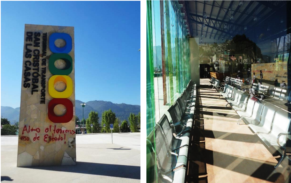
Foto 5. Terminal de transporte de corto recorrido San Cristóbal de Las Casas
