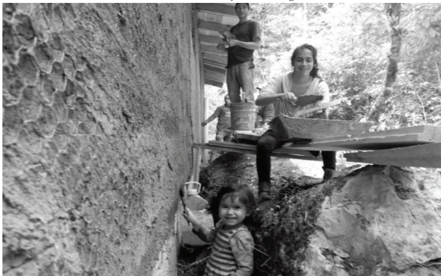
Foto 23. Construyendo el hogar
