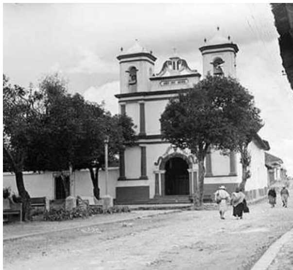
Foto 5. Templo del barrio de El Cerrillo
