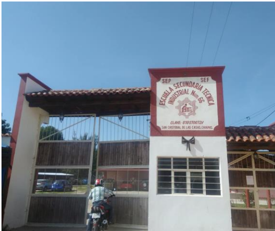
Foto 1. Puerta de acceso principal a la Secundaria 66
