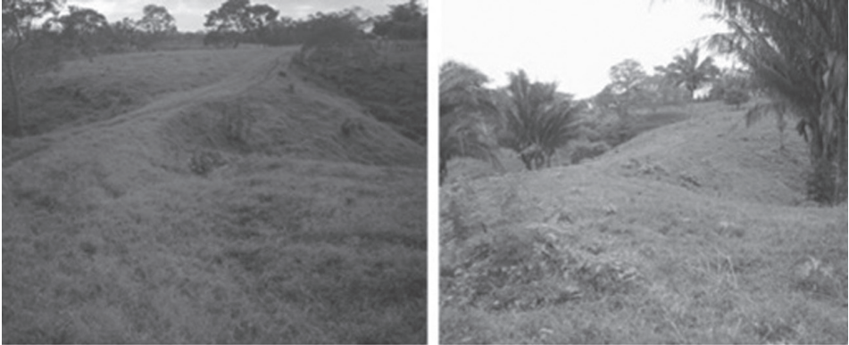
Foto 7 y 8. Cuando la loma no tenía una altura considerable, los terraplenes se construyeron al mismo nivel; los caminos los atraviesan de un lado a otro sin necesidad de excavar.
