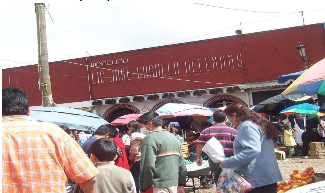
Foto 3: Fachada principal del mercado
