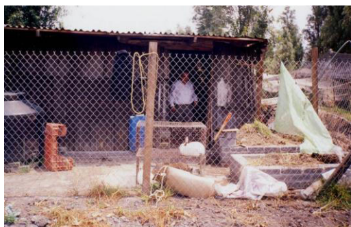
Mariano revisando los últimos detalles del módulo de producción, que se construyó en la chinampa de Marilú y Oscar en la comunidad La Conchita.
