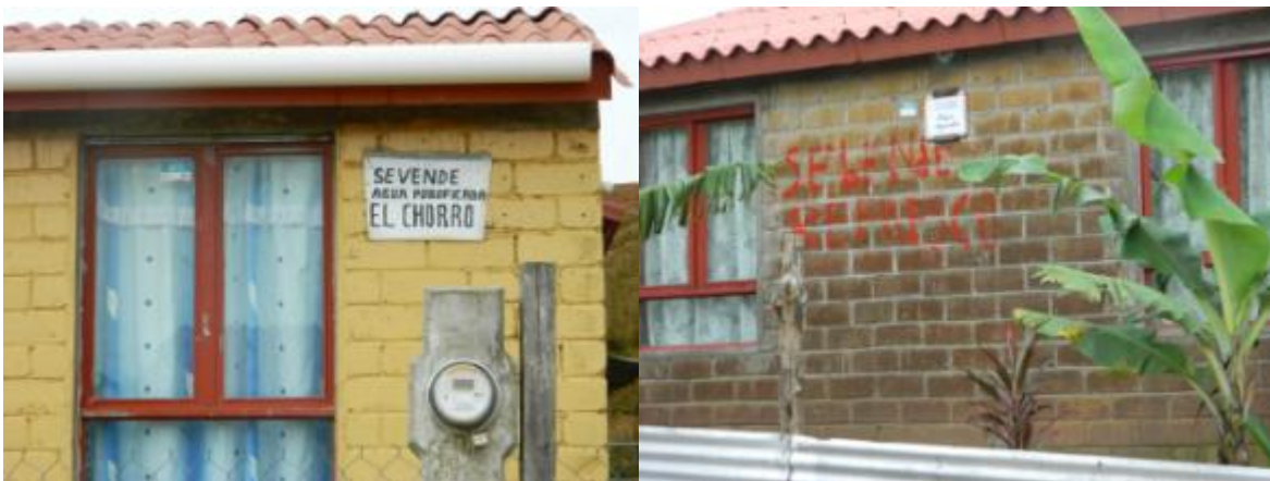
Foto 5 y 6. Pequeñas actividades comerciales en las viviendas.
