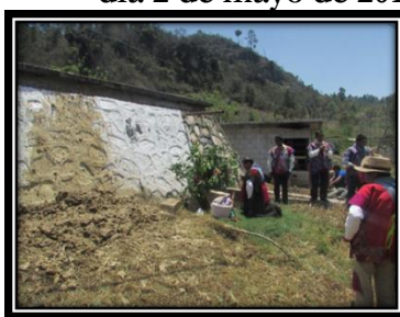
Fotografía 48: Sn. Isidro de la Libertad: Ofrenda en tanque de mampostería superficial de 30,000 litros de capacidad. Recién limpio para recibir el agua el día 2 de mayo de 2016
